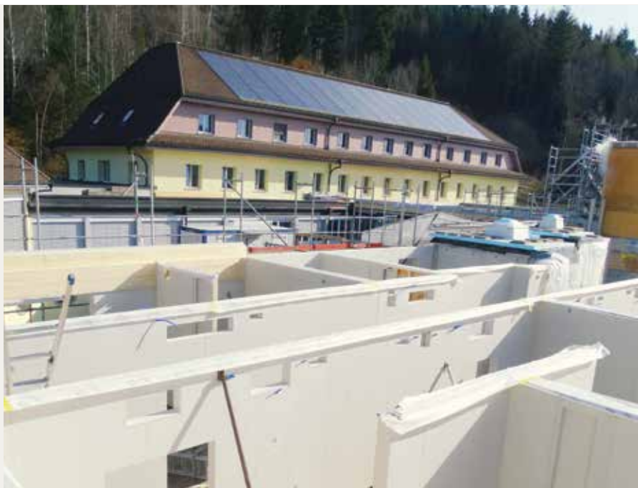
Nemocnica Adelheit, Švajčiarsko – Prefabrikované stenové panely s doskami Vidiwall.
